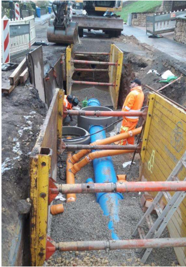
Tranchée pour pose des canalisations
