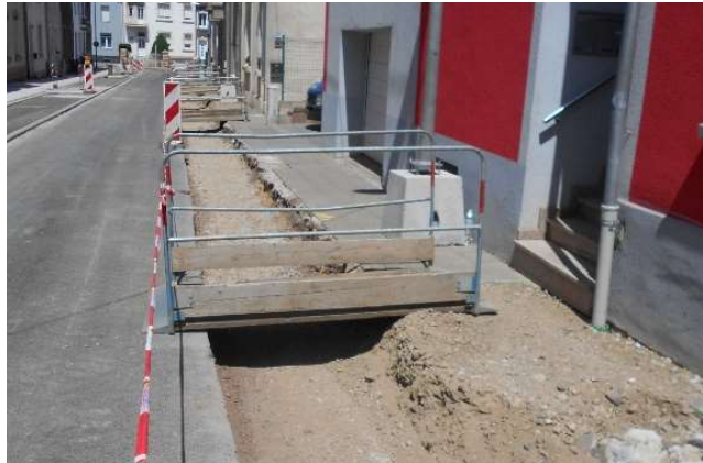
Tranchée pour pose réseaux secs avec accès piétons
